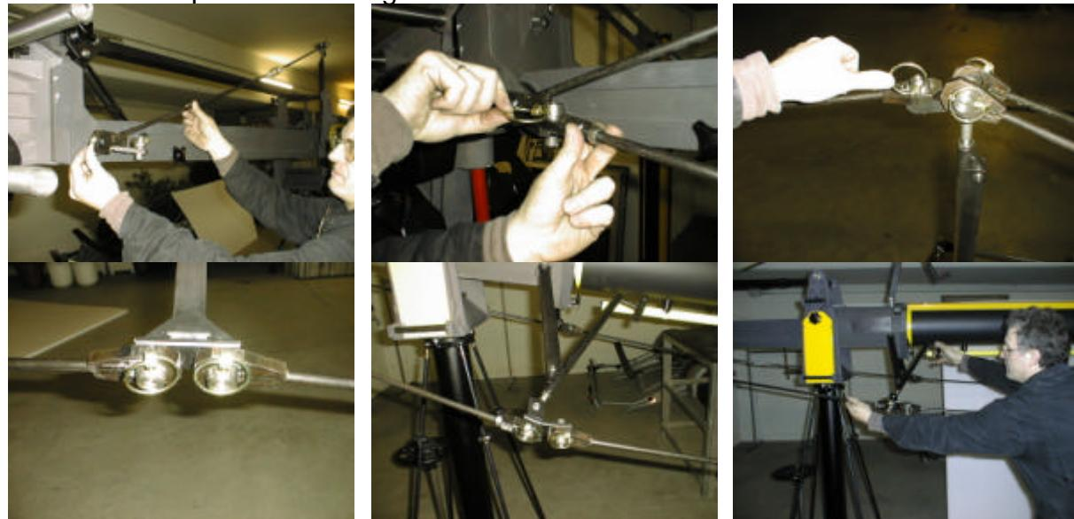
Nachdem Alle Stangen montiert und gesichert wurden, werden die Spannschlösser der hinteren Stangen zgedreht. Als letztes wird der obere und die zwei Seitenspanner gespannt.
